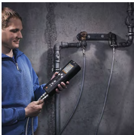
Zkouška provozuschopnosti bez napájecího zařízení
