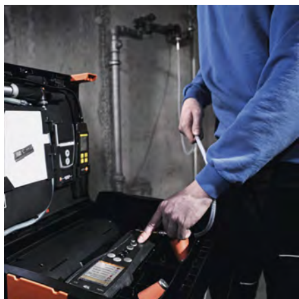
Automatická zkouška těsnosti
