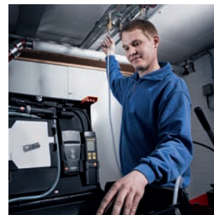
Contrôle des canalisations d'eau potable et d'eaux usées au moyen d'une sonde à haute pression (jusqu'à 25 bar)
