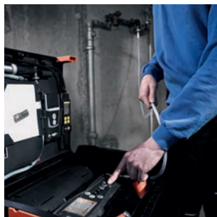
Contrôle d'étanchéité automatique
