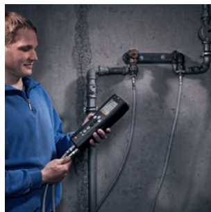
Contrôle de la capacité de fonctionnement
