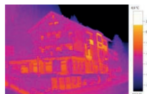
Image thermique avec testo ScaleAssist
