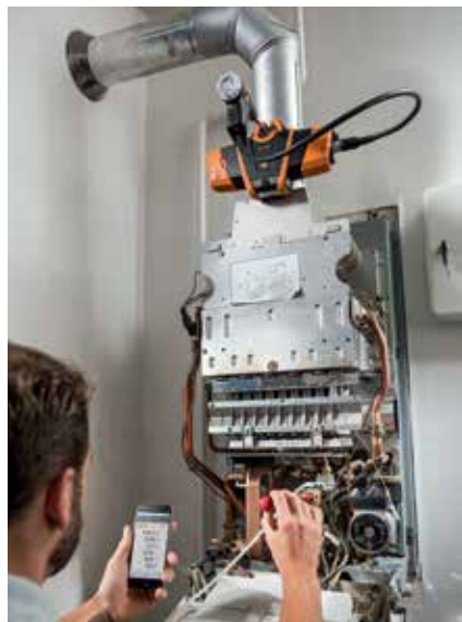
Abb. 8: Für die Einstellarbeiten unerlässlich ist ein Abgas-Analysegerät z. B. testo 330i
