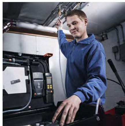
Kontrola rozvodu pitné vody a odpadního potrubí
