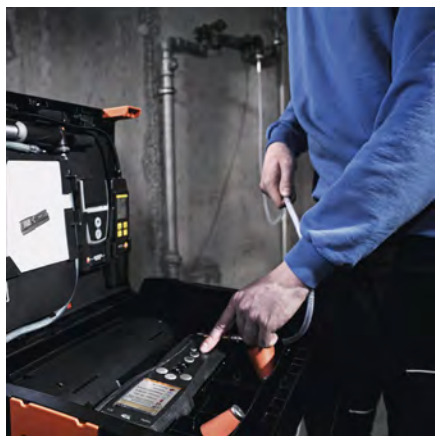
Automatická zkouška těsnosti
