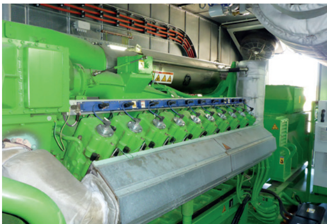
Une centrale de cogénération de 2G actuellement en service.
