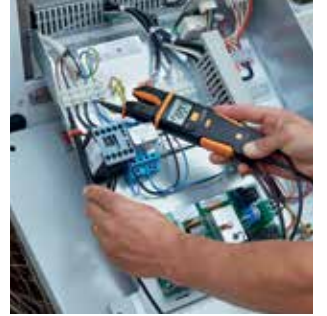
Kompresörde gerilim ölçümü
