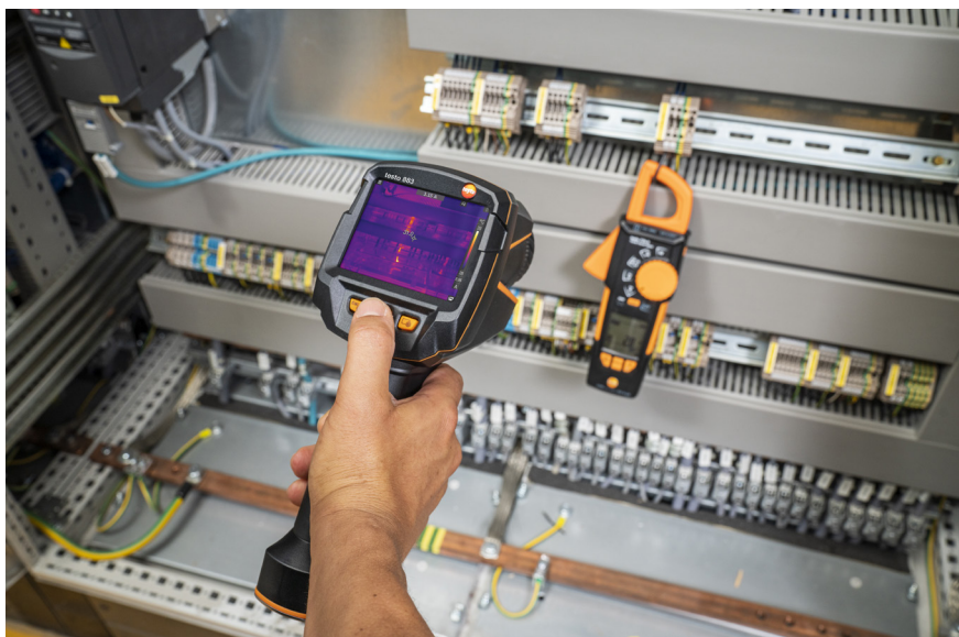
Une caméra thermique permet de localiser des défauts, d'entretenir les installations, de prévenir des dommages et de détecter des dangers.
