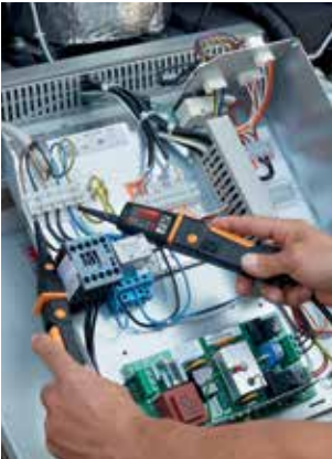
Kompresörde gerilim ölçümü
