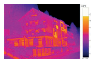
Wärmebild mit testo ScaleAssist
