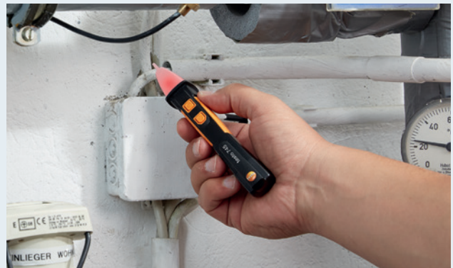
Prueba de tensión sin contacto en una caja de distribución hacia una instalación de calefacción con el testo 745.
