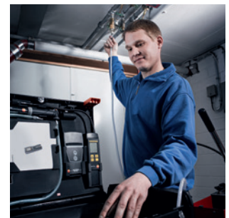
Trink- und Abwasserleitungsprüfung mit Hochdrucksonde bis 25 bar
