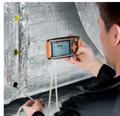
Измерение с помощью трубки Пито в воздуховоде
