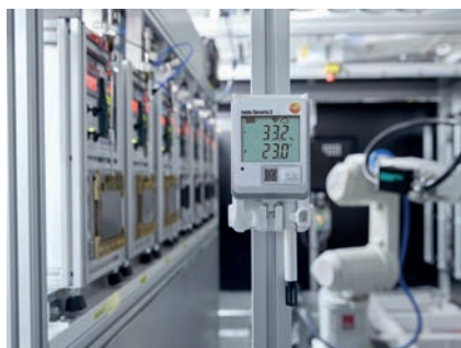
Surveillance de salles serveurs dans l'industrie (testo Saveris 2-T1)
