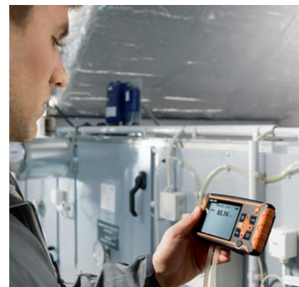
Измерение дифференциального давления с помощью соединительного шланга
