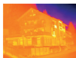
Wärmebild ohne testo ScaleAssist
