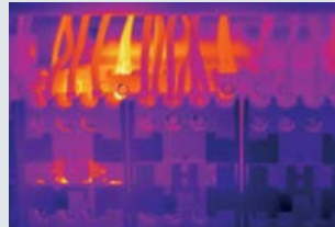
Manutenção das instalações: Detecção de temperaturas demasiado altas em fusíveis e componentes elétricos antes que apresentem falhas.
