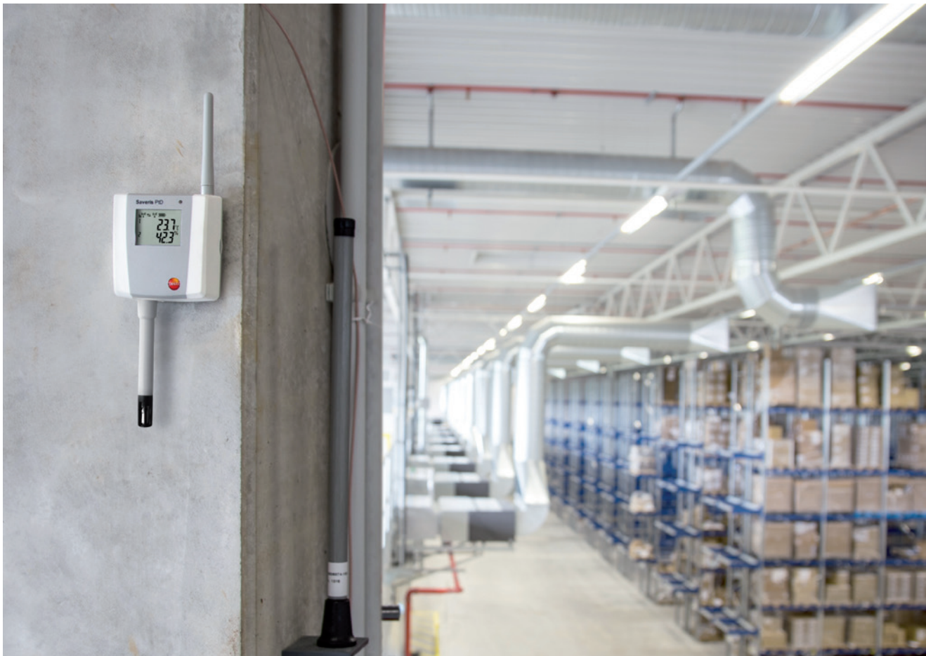
La supervisión constante de temperatura y humedad es imprescindible para el almacén de productos farmacéuticos.
