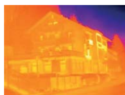
Épület hőképe testo SkálaAsszisztens nélkül
