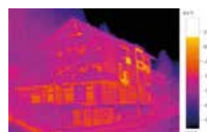
Warmtebeeld met testo ScaleAssist
