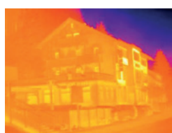
Wärmebild ohne testo ScaleAssist
